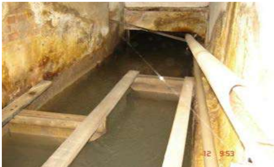
Ilustração 6 – Calha de mistura com chicanas
