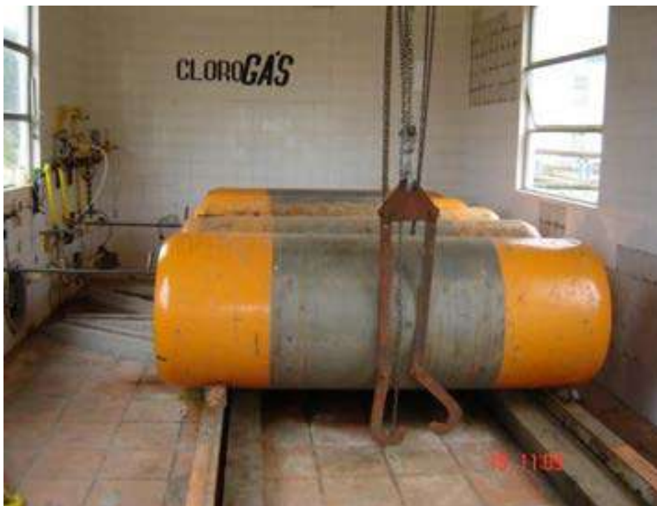
Ilustração 45 - Cilindros de cloro
