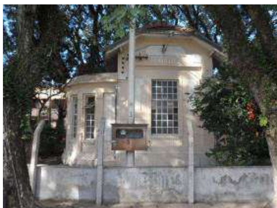
Elevatória Saldanha Marinho US-II. (Fonte SANEP)
