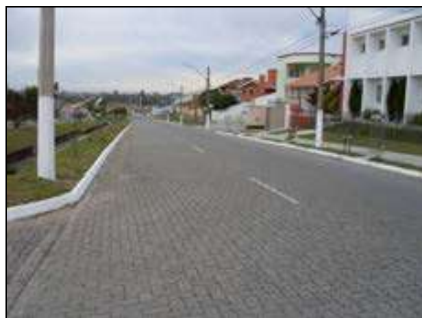
Figura 3.31 – Meio-fio após serviço de pintura
