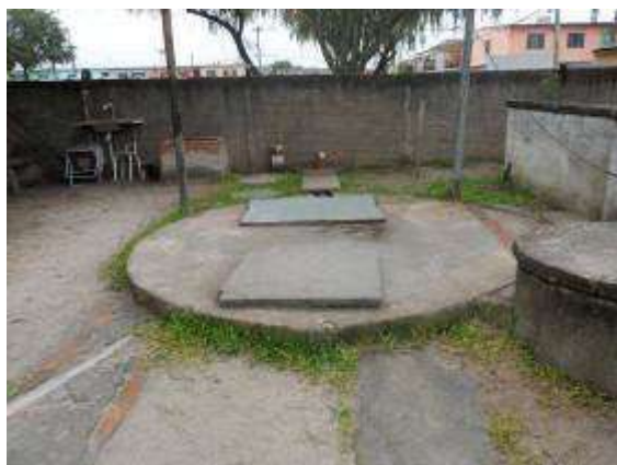
Local da Elevatória Guabiroba. (Fonte SANEP)
