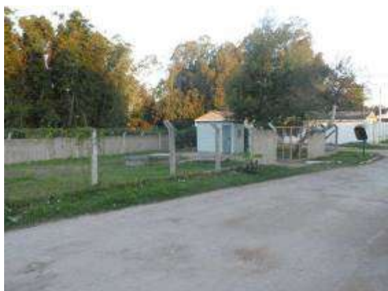
Local da Elevatória Cohab Fragata. (Fonte SANEP)
