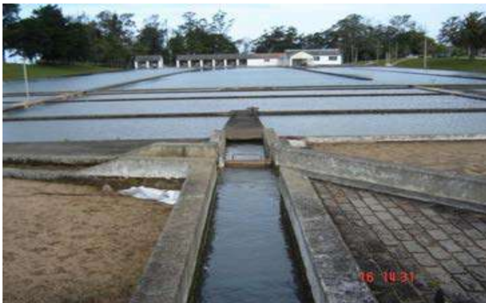
Ilustração 24 - Pré-filtros e decantadores
