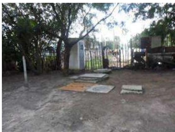
Local da Elevatória Vila Castilho. (Fonte SANEP)
