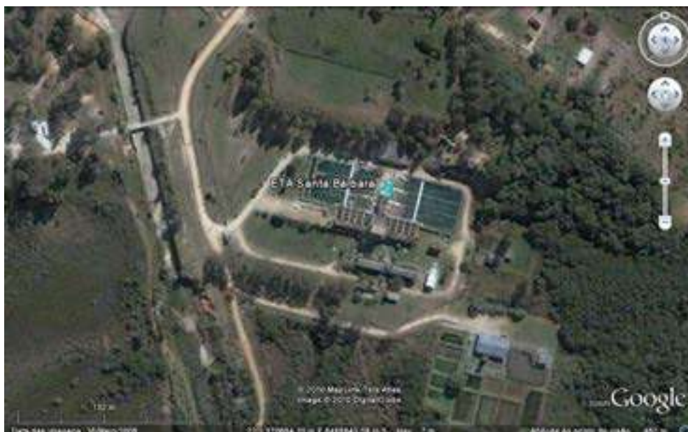
Ilustração 34 – Vista da ETA Santa Barbara
