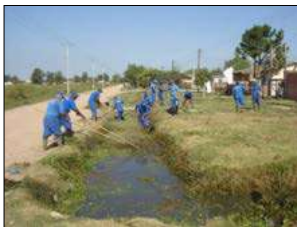
Figura 3.33 – Limpeza de valetas
