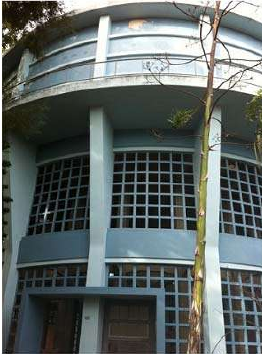
Ilustração 02 – Vista frontal do Reservatório R4.
