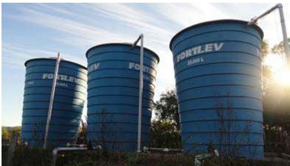
Ilustração 026 – Vista dos reservatórios, localizados na Colônia Quilombo.
