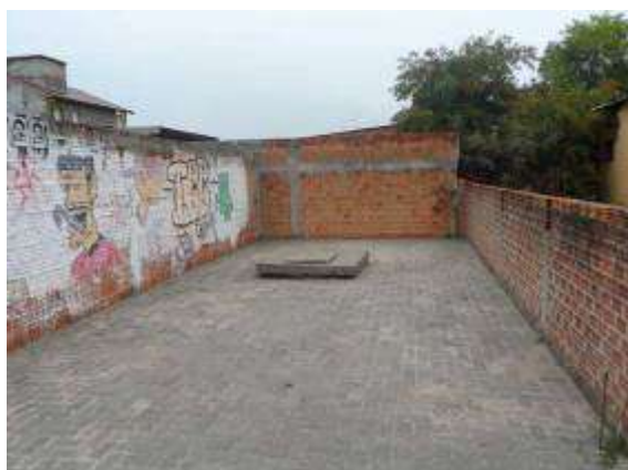
Local da Elevatória Toussaint (desativada). (Fonte SANEP)
