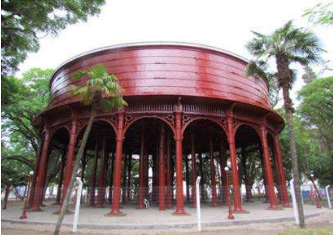
Ilustração 05 – Vista frontal do Reservatório R1.
