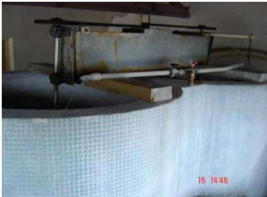
Ilustração 27 - Misturador de flúor
