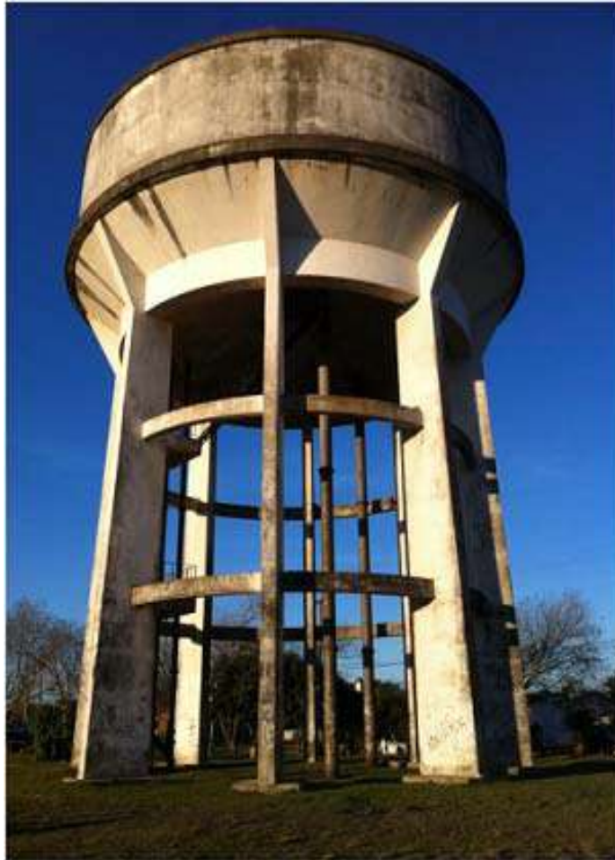
Ilustração 010 – Vista frontal do Reservatório R10.
