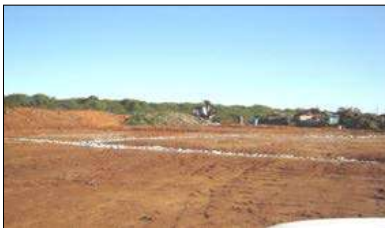
Foto 3.5 – Lançamento do sistema de drenagem de chorume
