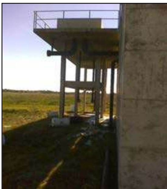
Figura 26 – Desarenador (Fonte STE)
