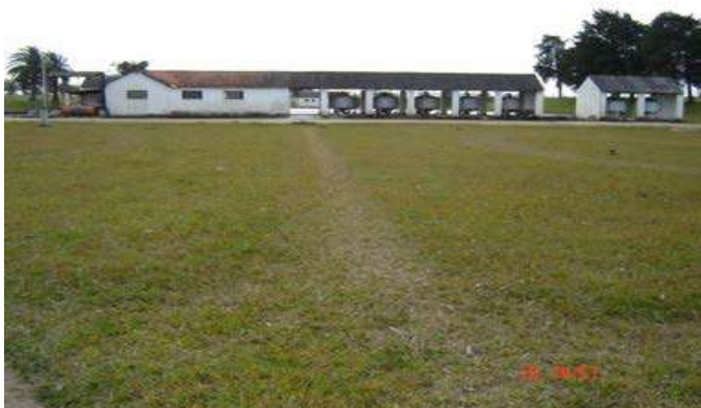
Ilustração 28 - Local do reservatório enterrado com 8.000m 3
