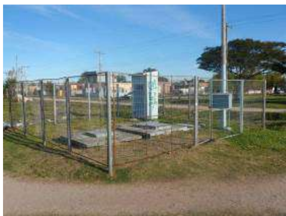
Local da Elevatória Meneghetti. (Fonte SANEP).
