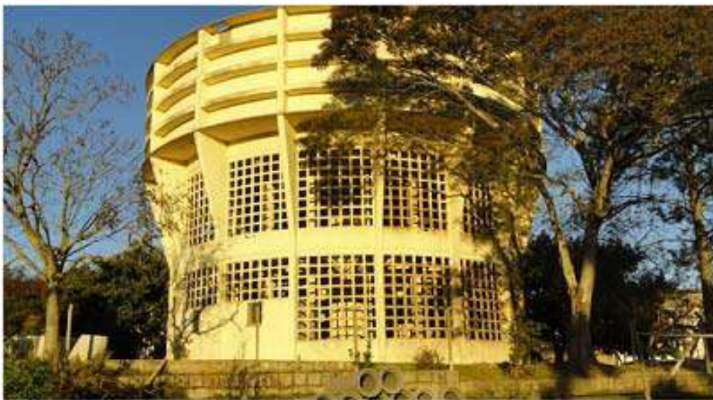
Ilustração 011 – Vista geral do Reservatório R-3.
