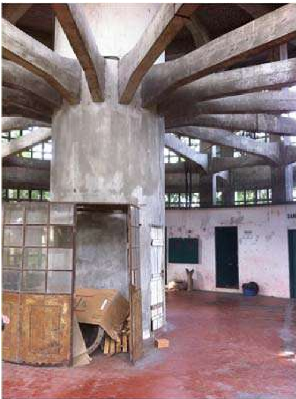
Ilustração 03 – Interior do Reservatório R4.
