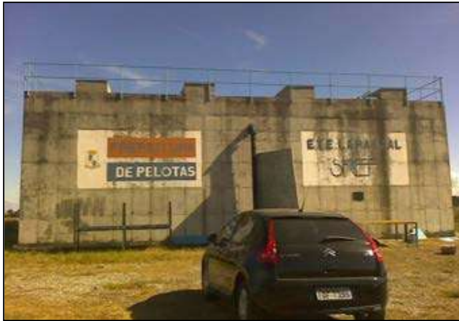
Figura 28 – Reator anaeróbio (Fonte STE)
