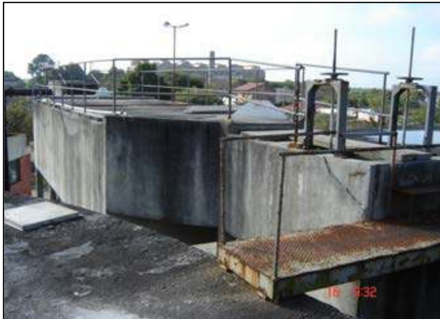
Figura 17 - Desarenador e calha Parshall (Fonte STE)
