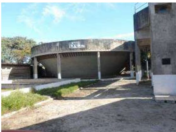
Elevatória US-III - RALF. (Fonte SANEP)
