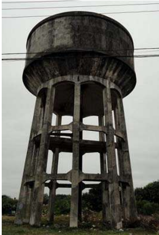
Ilustração 05 – Vista frontal do Reservatório R7.
