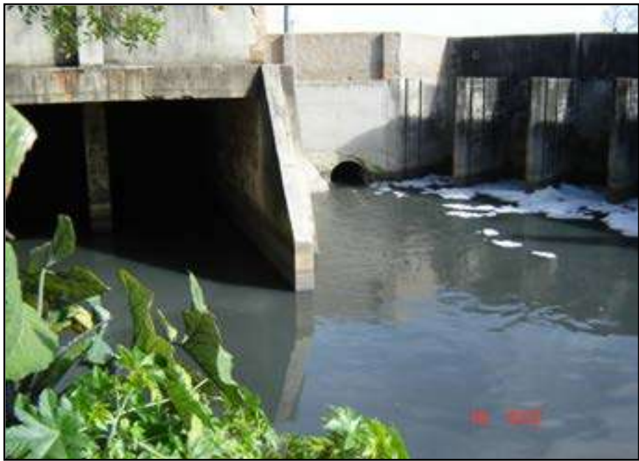
Figura 25 - Ponto de lançamento do efluente (Fonte STE)
