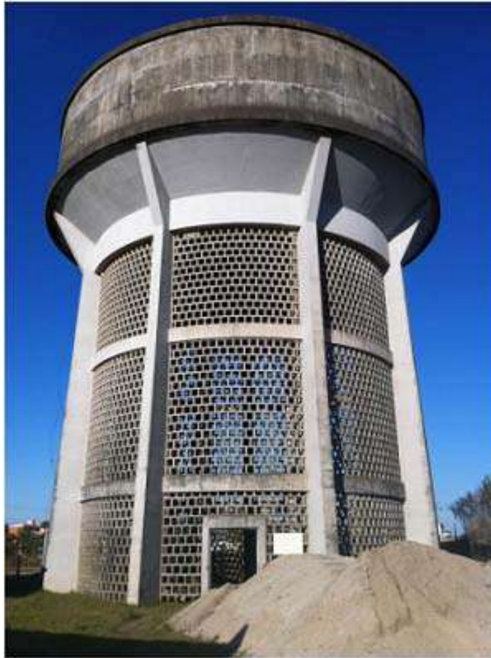
Ilustração 04 – Vista frontal do Reservatório R8.
