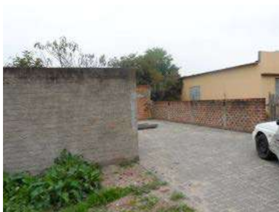
Entrada ELE – Toussaint (desativada). (Fonte SANEP)
