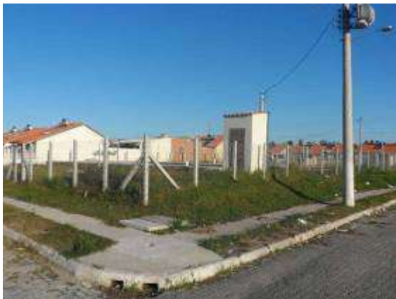
Local da Elevatória Eldorado. (Fonte SANEP)
