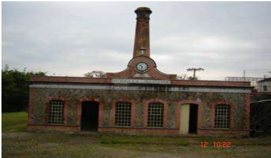
Ilustração 2 - Casa de Bombas e Museu do Moreira
