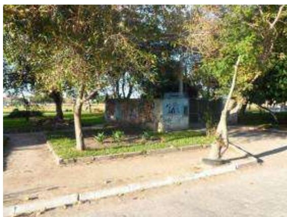
Local da Elevatória Ambrósio Perret. (Fonte SANEP)
