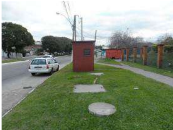
Local da Elevatória Ferreira Viana. (Fonte SANEP)
