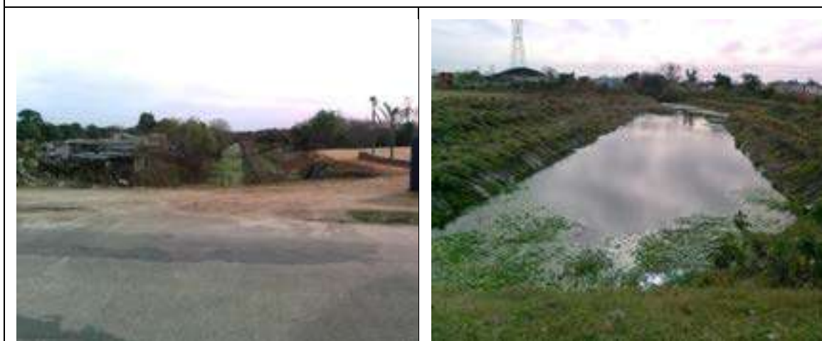
Figura 27: Vila Castilho, ponto crítico de alagamento.
