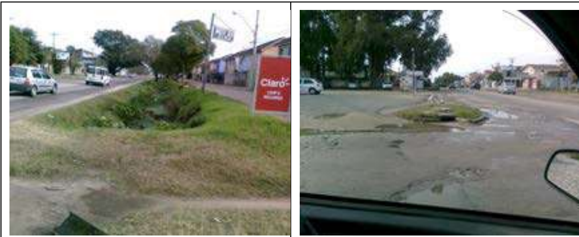
Figura 23: Avenida Salgado Filho, ponto crítico de alagamento.
