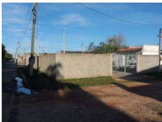
Local da Elevatória Navegantes. (Fonte SANEP)
