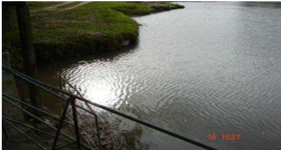
Ilustração 16 - Tomada de água Arroio Pelotas
